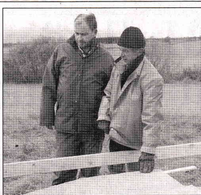
Räddar Slutarpsdösen. Jan Magnusson från Göteborgs och Bohusläns landsting och Peter Jankavs, Falbygdens museum diskuterar här detaljer i bygget när man byggde in Slutarpsdösens takhäll med isoleringsmaterial och plast för att rädda hällen från att frysa sönder i vinter.
