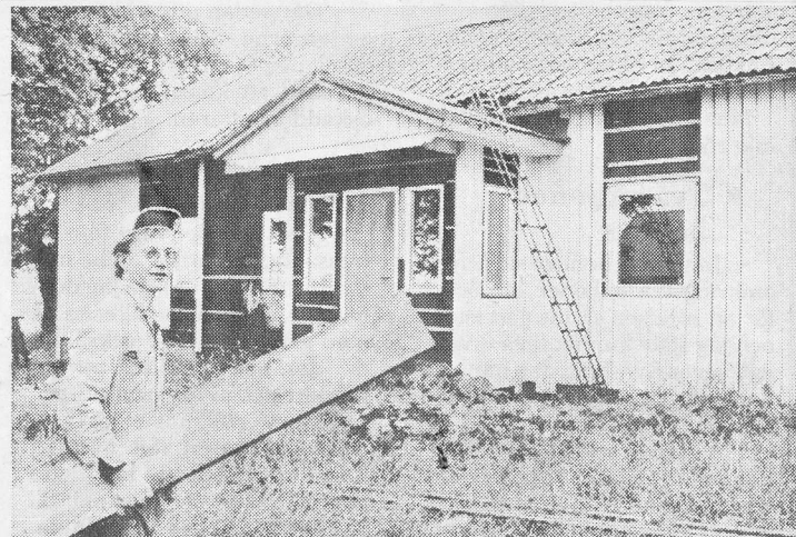
Johan Hägg håller själv på med renoveringsarbetena i Hullegården som består av två boningshus och ett uthus där det ska bli stall.
