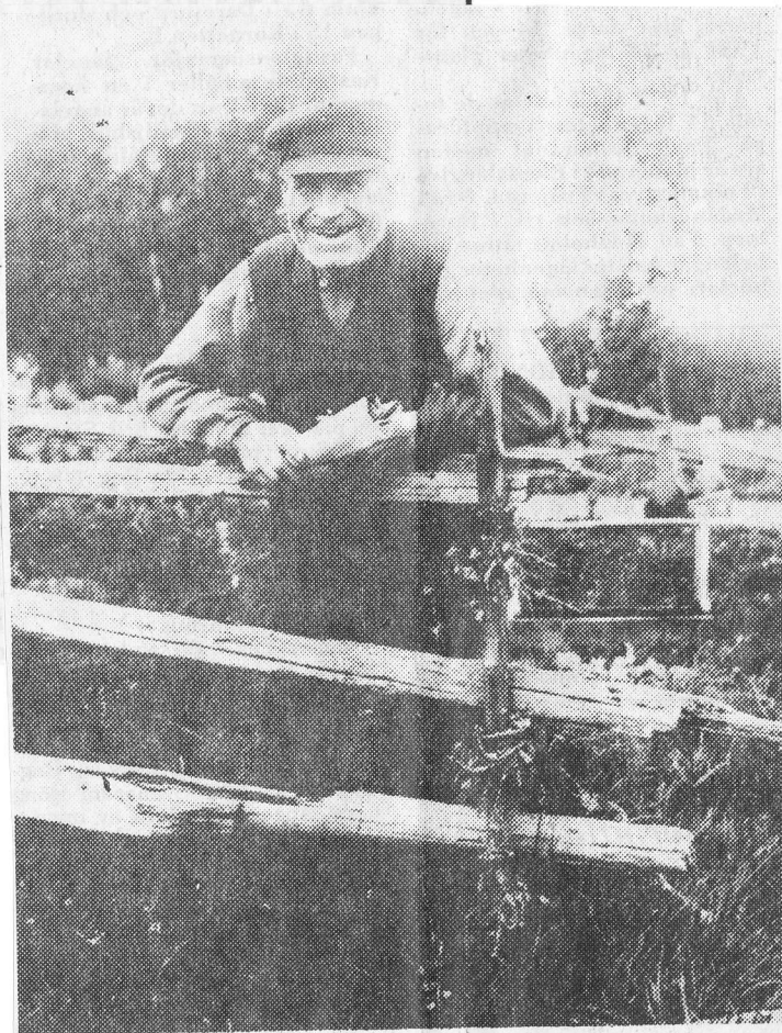
Kyrkvaktaren August Jonsson har varit och hämtat Falköpings Tidning. Den delen av skiegärdesgården som syns är nyiagad. Det kan man se på de lövvidjor som använts för sammanfogningen.
